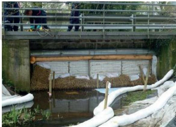
*Dispositif filtrant (paille et absorbants dans une structure grillagée) à 1,5 km à l'aval du point de fuite en amont des marais de la Brière*
