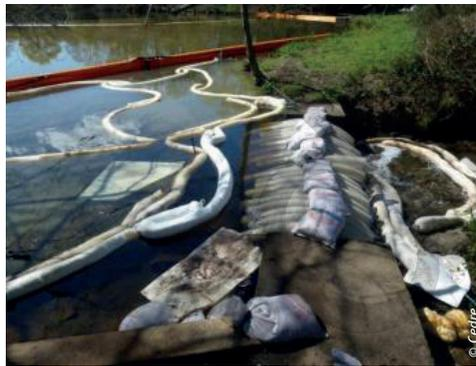
*Dispositifs de confinement dans le premier étang (barrages flottants et dispositifs absorbants) associés au relèvement du seuil du déversoir par des sacs de sable avec système de sous-verse par mise en place de buses souples pour contrôler le niveau d'eau*
