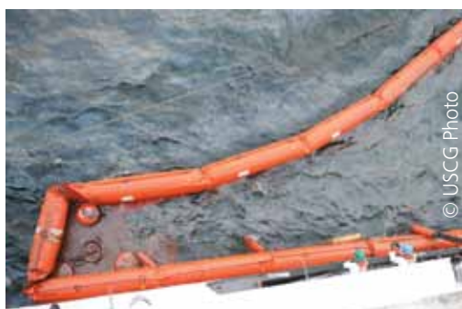
Utilisation de barrage concentrateur pour favoriser la récupération du pétrole, pollution du Golfe du Mexique (2010)
