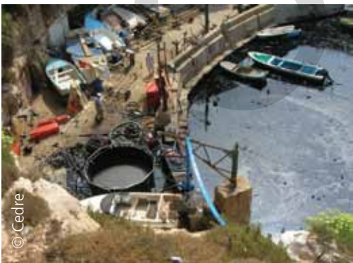
Stockage souple à armature
