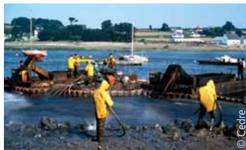
Récupération d'effluents de lavage sur le littoral
