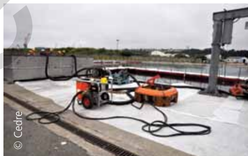
Chantier de récupération, stockage en zone portuaire
