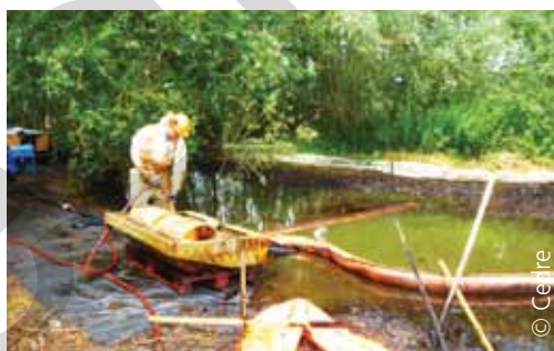
Nettoyage de récupérateur sur site d'intervention
