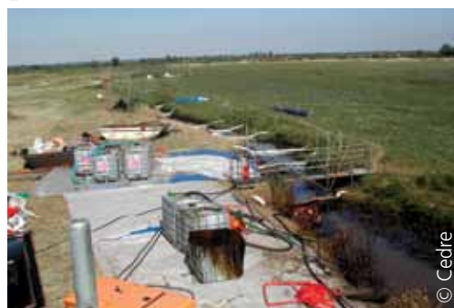
Confinement - récupération et stockage sur un petit cours d'eau
