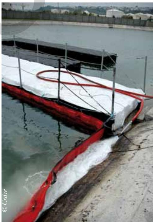
*Protection d'un ponton flottant par géotextile*
