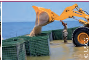
Barrière de gabions
