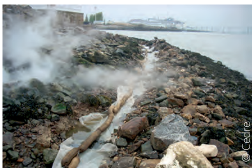
Récupération des effluents de lavage sur enrochement
