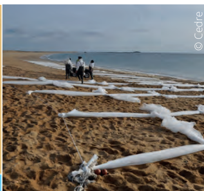
Lignes de captage préparées à marée basse en vue d'une opération de surfwashing * à la marée descendante suivante
