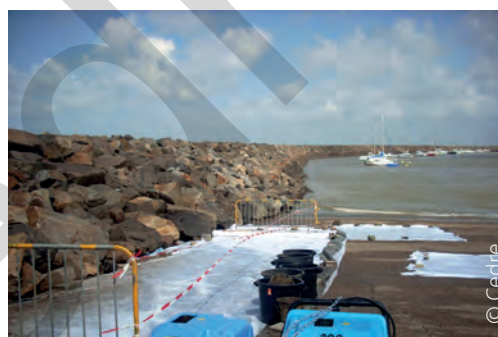
Préparation accès au chantier de nettoyage
