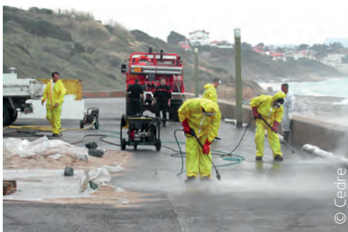
Lavage à l'eau chaude à haute pression
