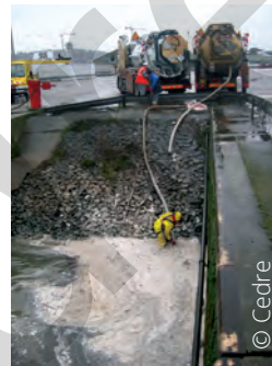
Aspiration directe et décantation dans le camion d'assainissement
