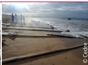
Pose de filets de captage sur estran* à marée basse
