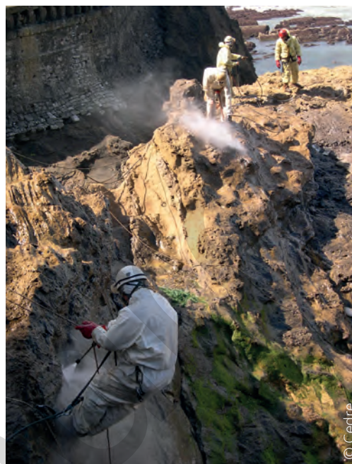
Nettoyage sur site d'accès difficile
