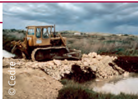
Barrage à empièchement non busé
