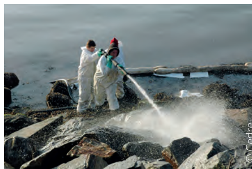
Flushing* sur enrochement
