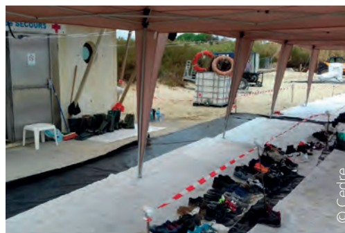
Chantier avec balisage d'espace propre
