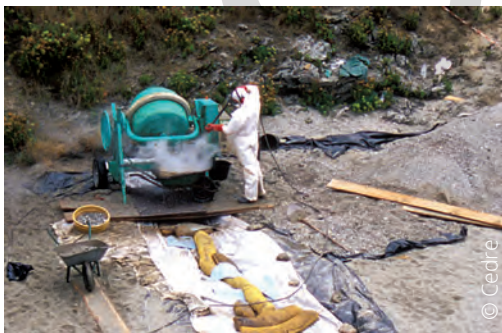
Lavage en bétonnière
