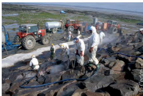
Chantier de nettoyage mécanique
