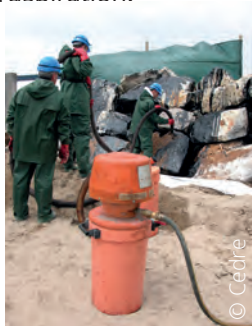
Système d'aspiration par le vide à double fûts
