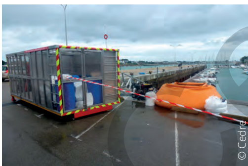
Zone logistique contigüe à un chantier de nettoyage
