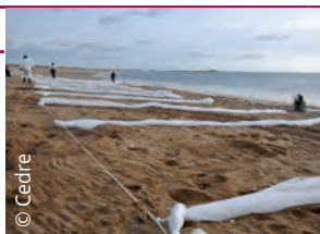
Pose de filets de captage sur estran* à marée basse
