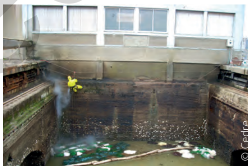
Chantier de nettoyage avec cordiste
