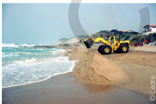
Opération de surfwashing *
