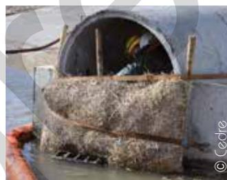
Filtration d'une prise d'eau, ou d'un émissaire, avec grillage et paille
