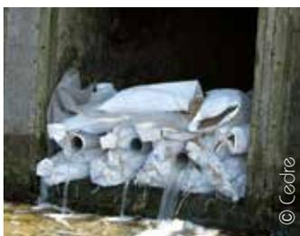
Obturation partielle d'un émissaire\* par talus et tuyaux inclinés
