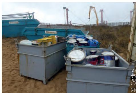
Entreposage primaire de produits chimiques issus du démantèlement d'un navire échoué
