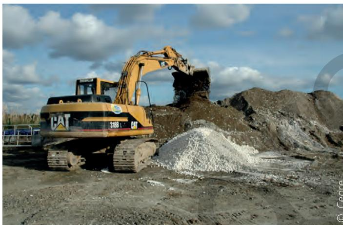
Traitement à la chaux par mélange mécanique
