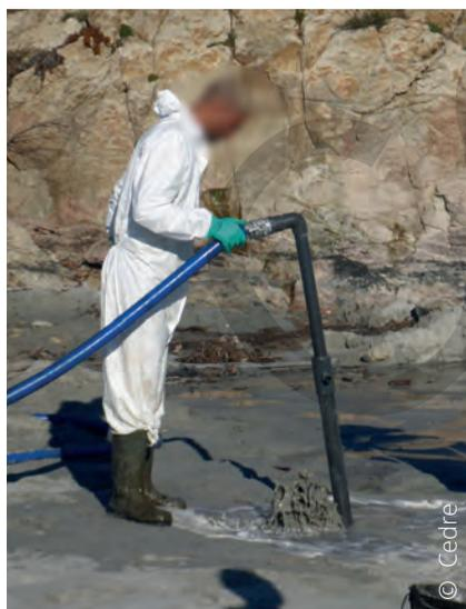
*Remise en suspension du polluant piégé dans les sédiments à l'aide d'une lance à jet d'eau basse pression (flushing)*
