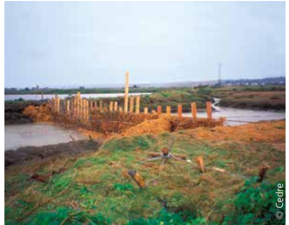
Barrière filtrante en paille à l'entrée d'un étier
