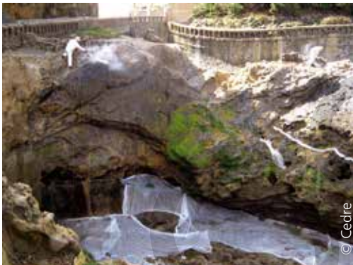
Récupération d'effluents sur voile d'hivernage et barrage absorbant
