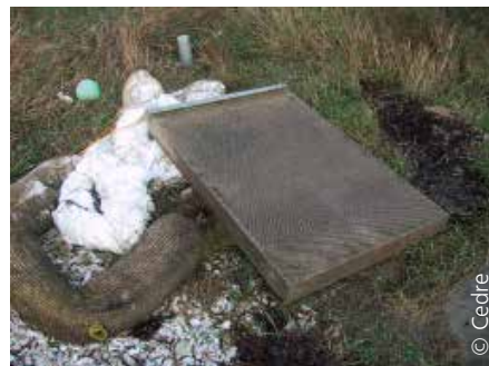
Dispositif pérenne de filtration sur une prise d'eau ostréicole : glissière (←) et cartouche à garnir d'absorbants (→)
