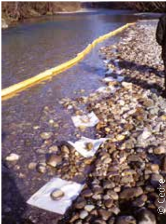
Dispositifs de confinement : déviation en rivière avec zone de récupération garnie de feuilles absorbantes
