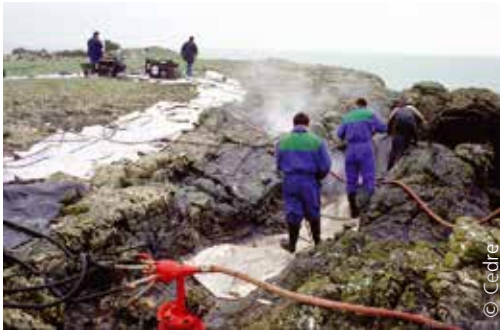
Géotextile pour la récupération des hydrocarbures et en protection de site
