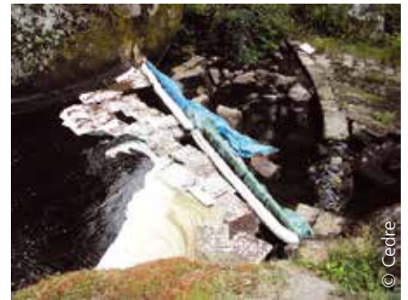
Dispositifs de confinement : déviation en rivière avec zone de récupération garnie de feuilles absorbantes
