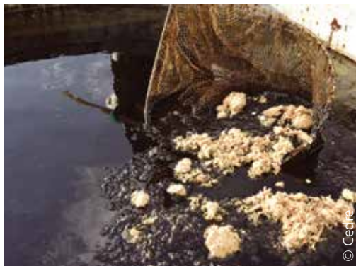
Récupération sur l'eau d'absorbants hydrophobes flottants en vrac souillés par des hydrocarbures
