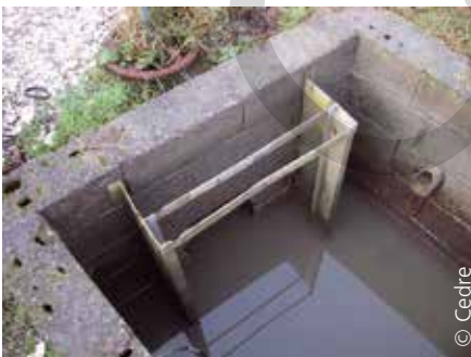
Dispositif pérenne de filtration sur une prise d'eau ostréicole : glissière (←) et cartouche à garnir d'absorbants (→)
