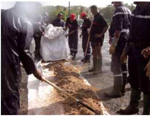
Construction d'un barrage à façon : grillage, géotextile, bagasse
