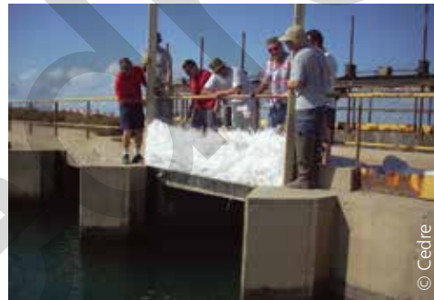
Barrière filtrante en fibres hydrophobes sur une prise d'eau d'un bassin salicole
