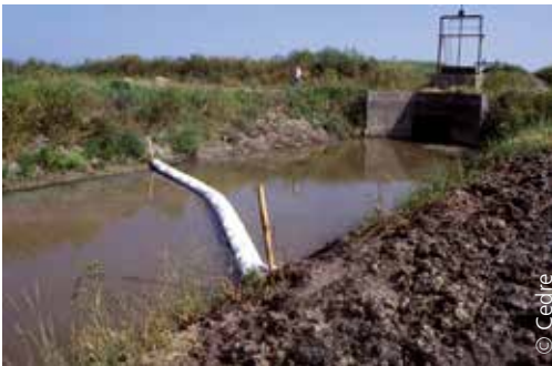
Barrière filtrante en fibres hydrophobes sur une prise d'eau de polder agricole
