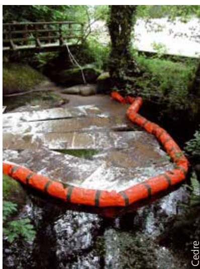
Confinement par barrage flottant et récupération à l'aide de feuilles
