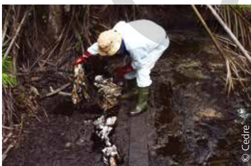
Récupération au sol à l'aide d'absorbants de fortune (combinaisons en polypropylène usagées)
