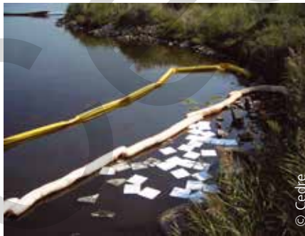
Dispositifs de confinement : déviation en rivière avec zone de récupération garnie de feuilles absorbantes
