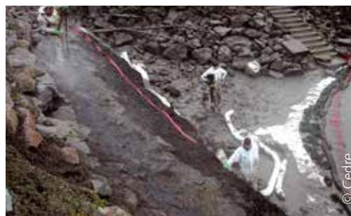
Protection par barrage et utilisation de feuilles et écheveaux pour récupérer le polluant
