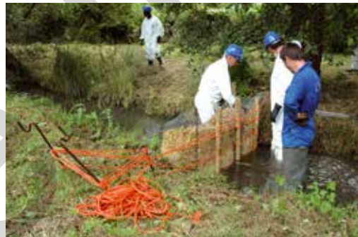
Installation d'un barrage en paille sur une rivière
