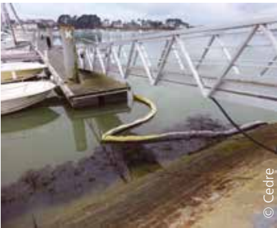
Protection par barrages absorbants
