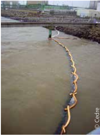
Dispositifs de confinement : barrages absorbants déployés pour dévier le polluant dans une zone de récupération
