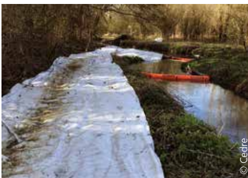
Cheminement de protection
