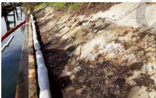
Barrages absorbants pour piéger le polluant entraîné par le ruissellement
