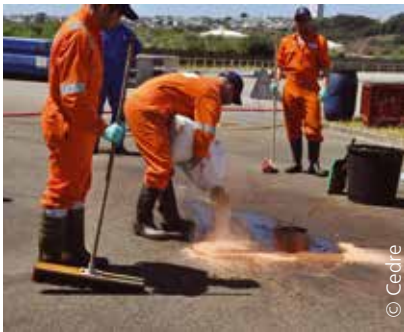
Construction d'un merlon pour confiner
