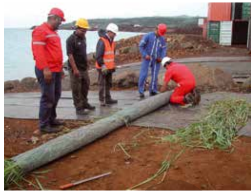
Construction d'un barrage à façon : grillage et végétation
