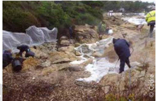
Absorbants positionnés au fil de l'écoulement des effluents de lavage et film d'hivernage en protection de la végétation
