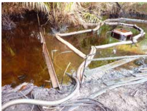
Confinement et récupération à l'aide de barrages absorbants
