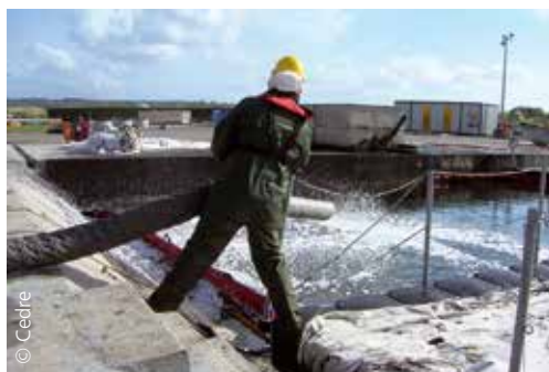
Application d'absorbants à l'aide d'un projecteur à air
