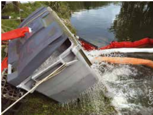
Refoulement d'effluents pollués vers une zone de confinement via un dispositif filtrant (poubelle percée remplie d'absorbants)
