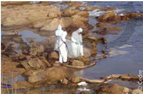
Barrage absorbant pour le confinement, écheveaux pour la récupération et le filet de captage pour les projections
