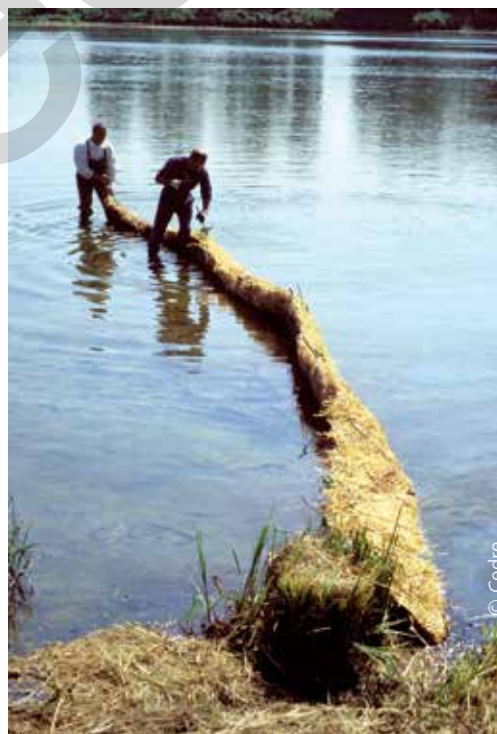
Installation d'un barrage filtrant constitué de paille, branchages et grillage
