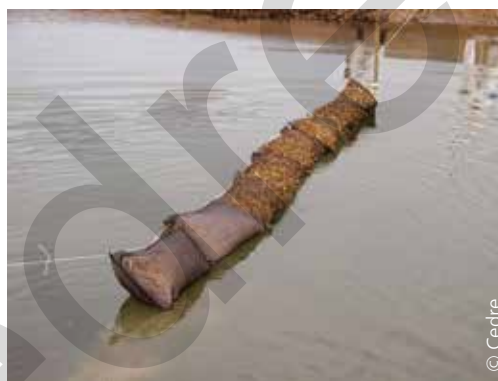
Barrage à façon : poches ostréicoles garnies d'absorbant de fortune (paille)
