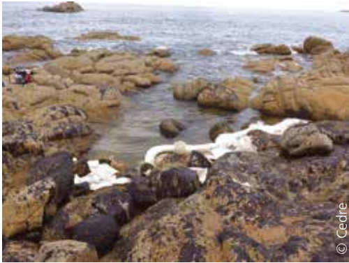
Barrage absorbant disposé afin de délimiter et circonscrire la zone à nettoyer
