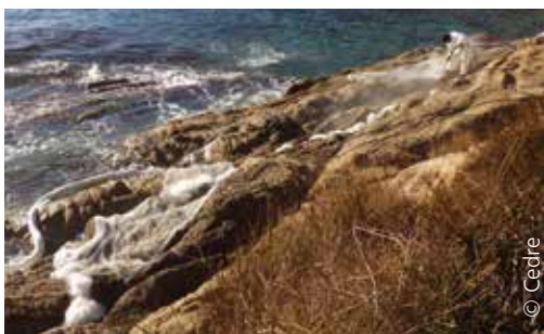
Barrages absorbants et filets utilisés pour fixer les hydrocarbures contenus dans les effluents d'un chantier de nettoyage
