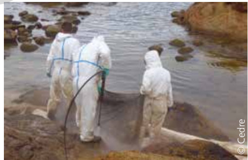
Filet de captage pour récupérer les polluants présents dans les effluents de lavage, barrage absorbant pour confiner
