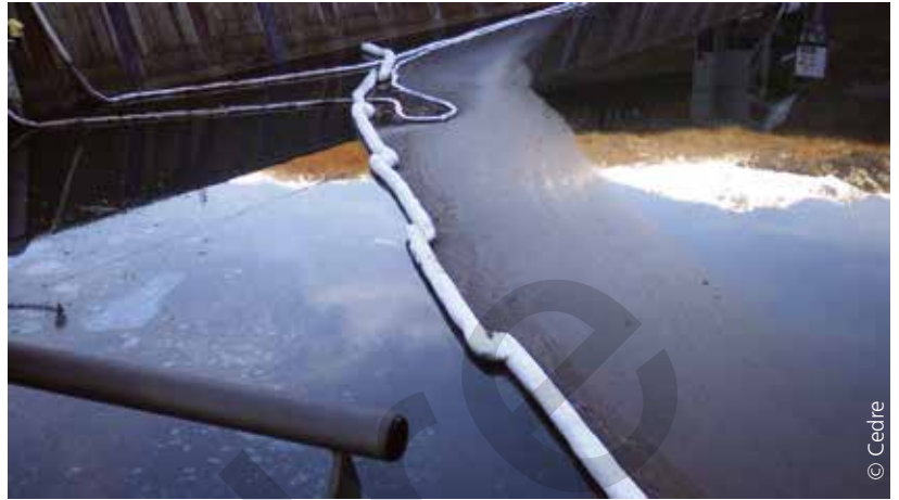
Dispositifs de confinement : barrages absorbants déployés pour dévier le polluant dans une zone de récupération
