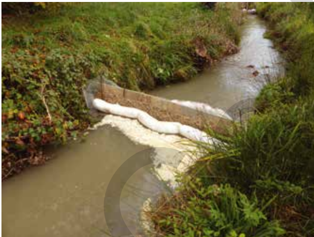
Confinement par barrage à façon : absorbant en vrac, barrage, grillage à poule et paille
