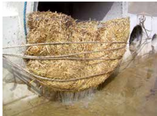
Dispositif filtrant en paille à la sortie d'un émissaire
