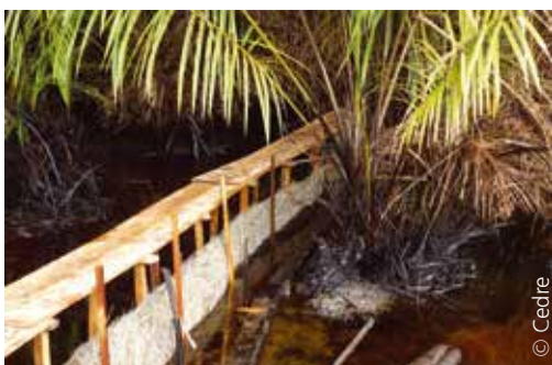
Cartouche filtrante installée sous la passerelle (←) et garnie de fibres de palmier (→)
