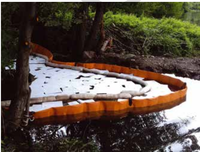
Confinement par barrages manufacturé et absorbant, feuilles
