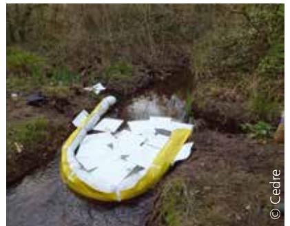
Dispositifs de confinement à l'aide de barrages absorbants et récupération à l'aide de feuilles du polluant stagnant dans le ruisseau
