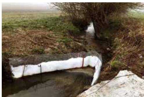
Barrage à façon constitué de grillage et fibres polypropylène en vrac
